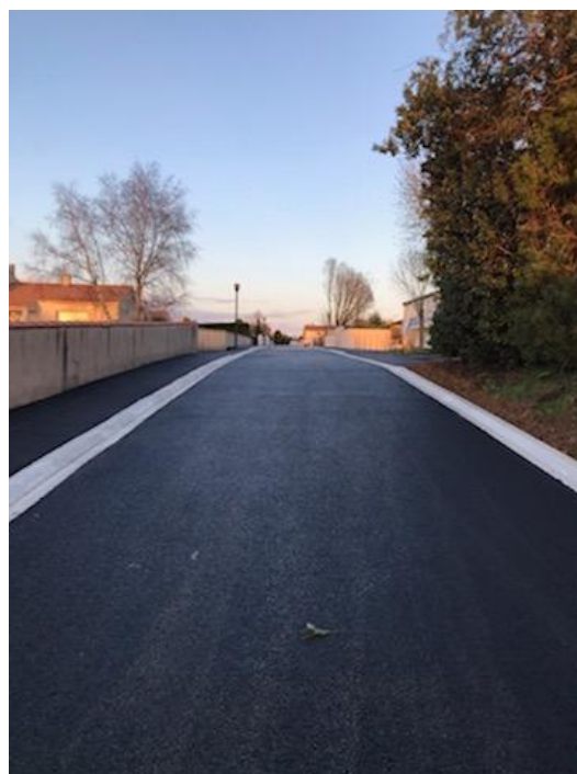
Après les travaux
